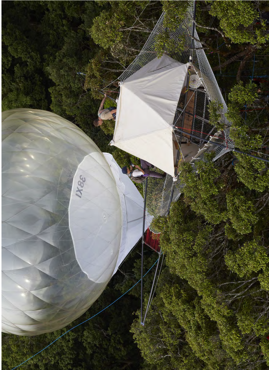
Installation de l'Étoile des cimes accompagnée de la Bulle des cimes Khammouane, Laos 2012
