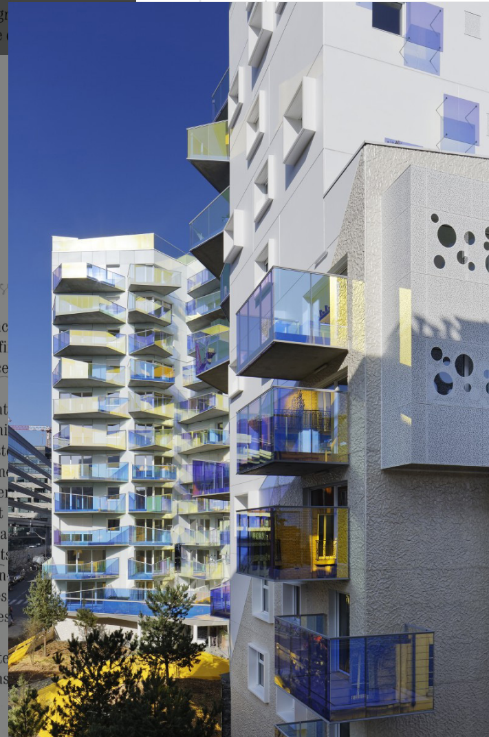
Bernard Bülher, Immeuble Fulton, Paris, 13e arrondissement
