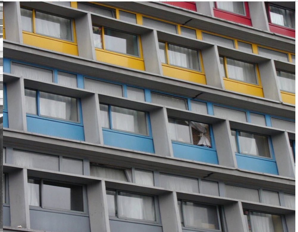
Façade de la Cité de Refuge, suite aux travaux de rénovation
