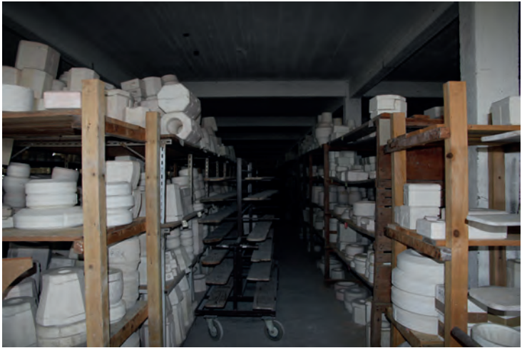
fig. 21 : Rez-de-chaussée de l'ancienne manufacture de porcelaine de Coulevre, 2020.
