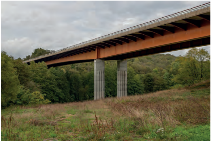
fig. 6 : Viaduc de la Gartempe, Bessines-sur-Gartempe, Haute-Vienne, Nouvelle Aquitaine, ARN.
