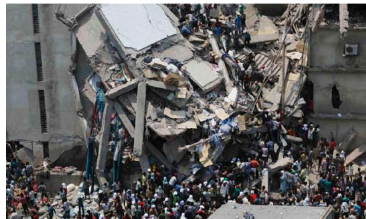
Effondrement du Rana Plaza, 24 Avril 2013, au Bangladesh. Immeuble abritant 6 usines de confection de vêtements, s'effondre sur les ouvriers, très nombreux, alors au travail.
